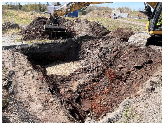
Figur 2.4: Bilder som viser prøvegroppen gravd ved prøvepunktet PG5.313, samt oppgravde masser. Foto: Multiconsult.
