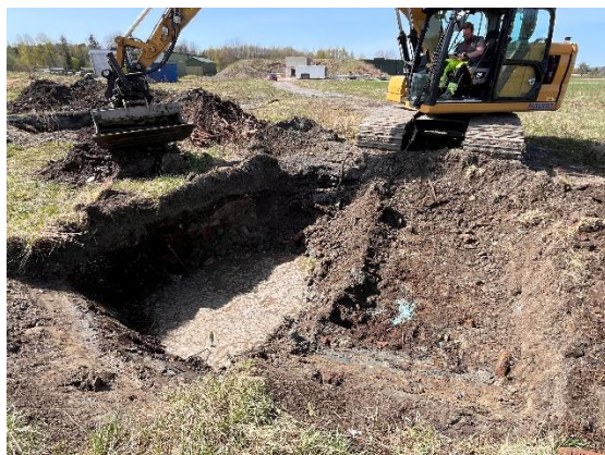
Figur 2.3: Bilder som viser prøvegroppen gravd ved prøvepunktet PG5.82, samt oppgravde masser. Foto: Multiconsult.
